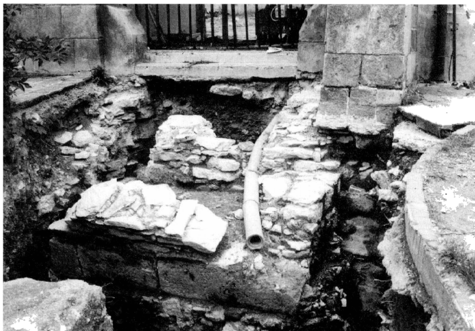
Obr. 3. Banská Bystrica – barbakan. Základové murivo prístupovej cesty, s opracovanými kvádrmi a časťou nábehu klenutia. Foto: M. Mácelová.
