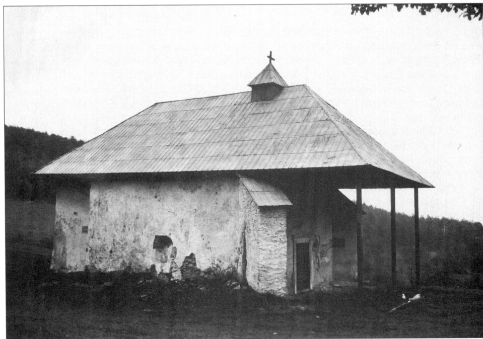
Obr. 2. Pohľad zo severozápadu.
