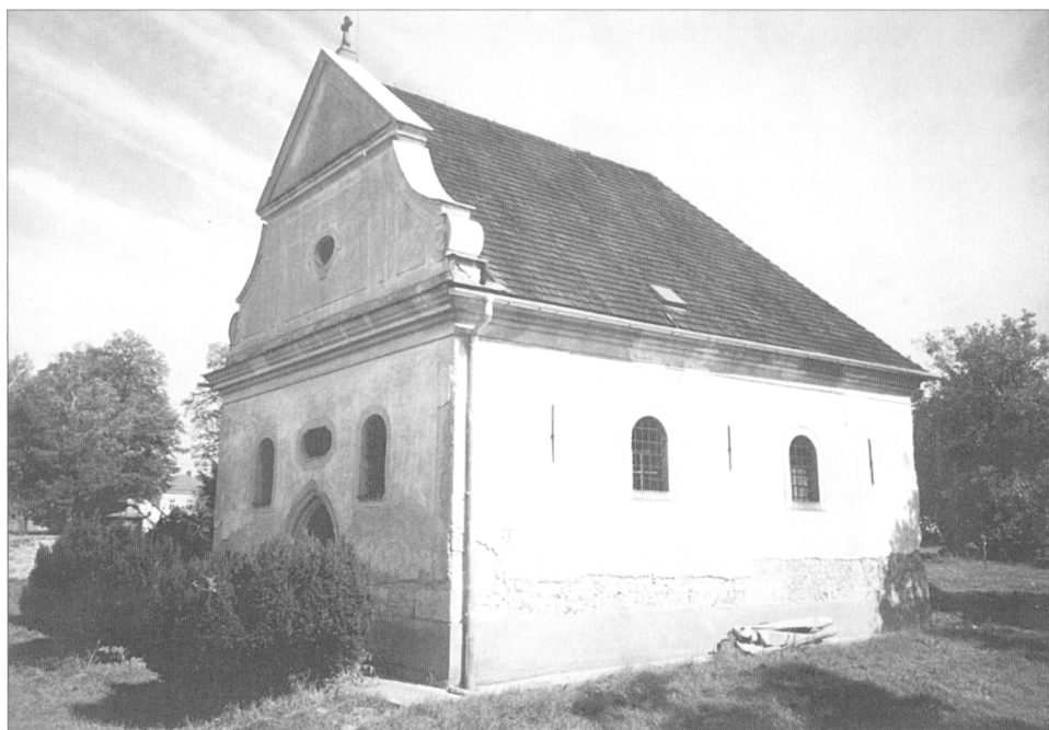
Obr. 1. Štípa, hřbitovní kaple – pohled od JZ (foto: R. Vrla 2002).
