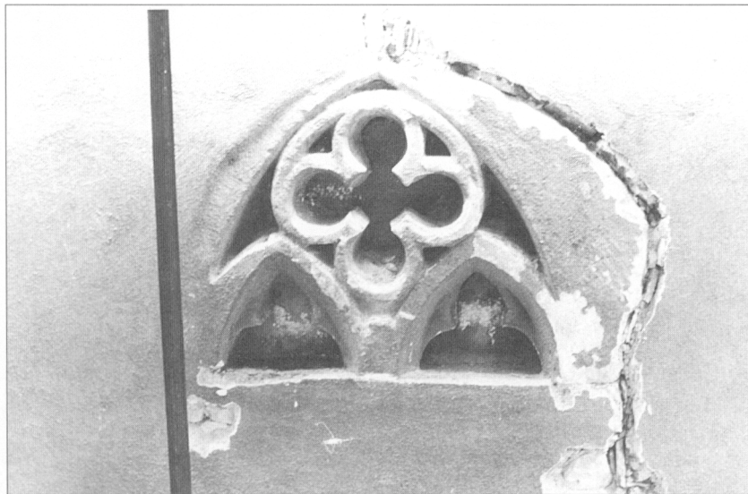
Obr. 14. Želechovice, farní kostel sv. Petra a Pavla – detail fragmentu kružbového okna ve V zdi presbytáře (foto: R. Vrla 1994).
