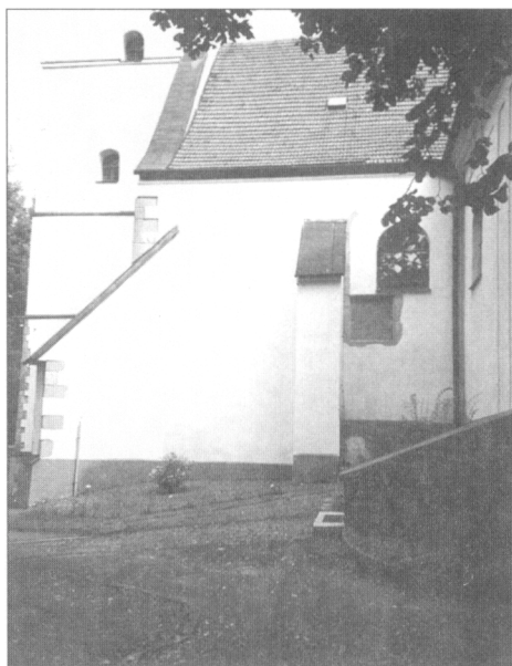
Obr. 12. Brumov, farní kostel sv. Václava – J strana kostelní lodi; vlevo opěrný pilíř s rytými obrázky na armovacích kvádrech, vpravo u stávajícího okna fragment ostění okna gotického, hrotitého (foto: R. Vrla 2002).
