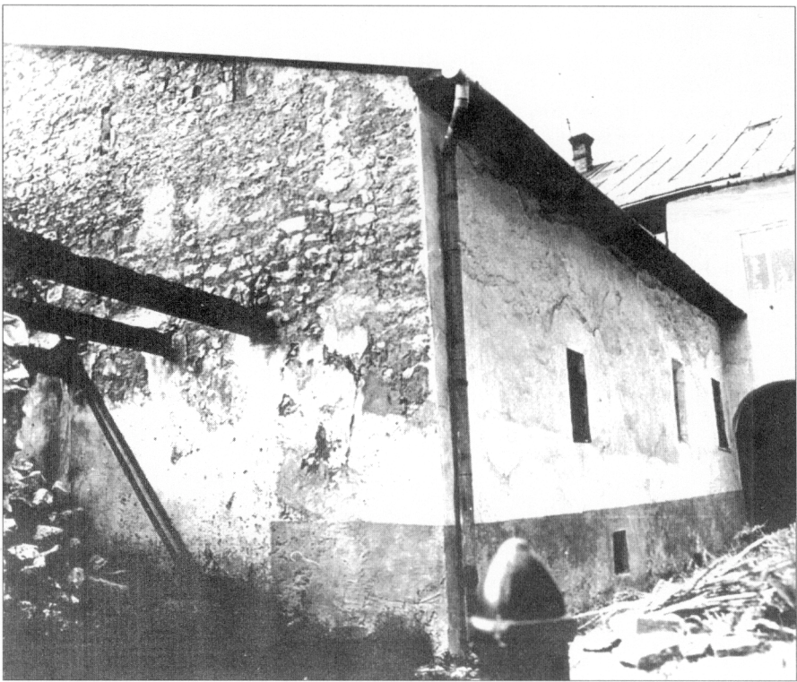
Obr. 9. Spišské Podhradie, dom č. 630, dvorové krídlo so zabudovaným jednopriestorom.
