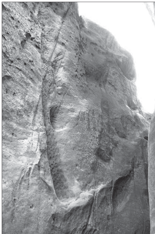
Obr. 18. Klokočský Hrádek, stopy staršího vstupu, dráze ve stěně jižního bloku po zárubni dveřního rámu a kapsa po závoře. Foto I. Peřina, 2005.
