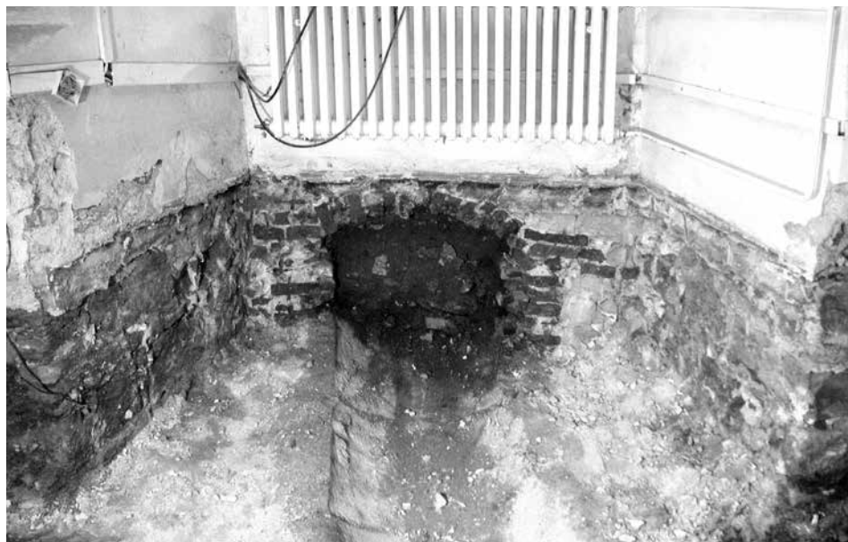
Obr. 20. Klementinum čp. 190, východní část severního křídla jezuitské koleje, pohled od severu na jižní obvodovou zeď. Pod ní se nalézá zaklenutá cihlová stoka (Z01) se dnem z mohutných pískovců. Výzkum NPÚ ÚOP v Praze č. 2010/11, sonda U. Foto J. Havrda.
