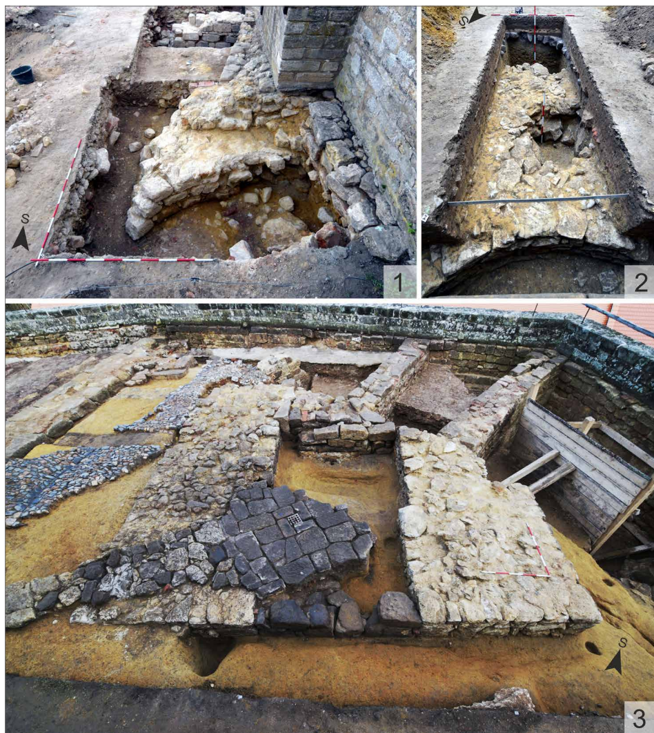
Obr. 3. Fotografická dokumentace nálezové situace zděných konstrukcí nejstarší fáze hradu Kost. 1 – konstrukce válcové věže – 403; 2 – konstrukce válcové věže, bergfritu – 409; 3 – konstrukce věžové brány – 426. Foto J. Košek.
