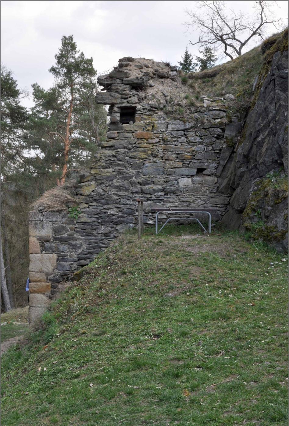
Obr. 6. Hrad Buben, okr. Plzeň-sever. Zbytky dvorního průčelí brány s otvorem pro odvod kouře z průjezdu. Foto J. Varhaník, 2019.
