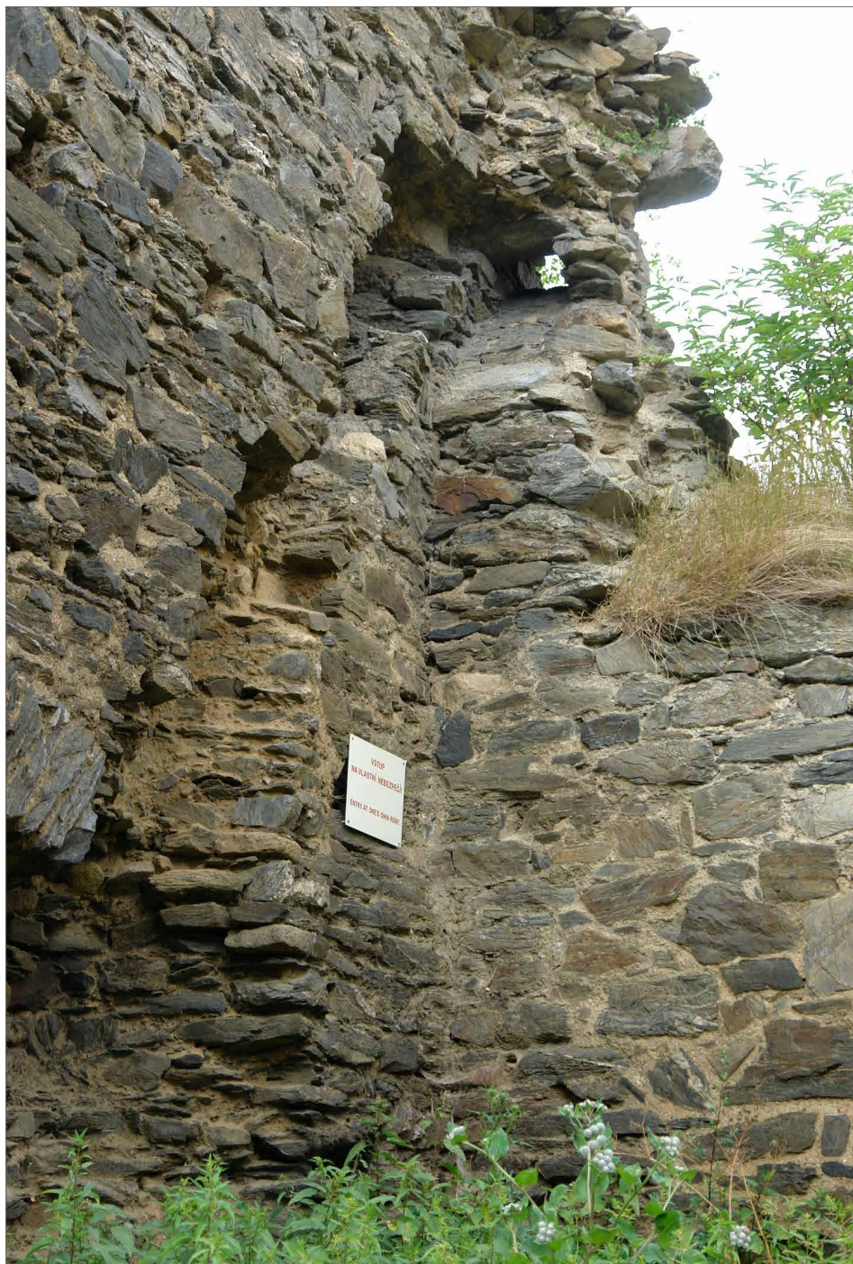
Obr. 4. Hrad Buben, okr. Plzeň-sever. Západní kout průjezdu brány do jádra s druhotně vysekaným kouřovodem a starším otvorem k odvodu kouře. Foto J. Varhaník, 2008.
