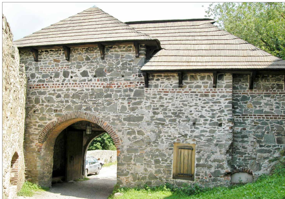
Obr. 11. Hrad Kunětická hora, okr. Pardubice. Vnitřní průčelí páté brány. V ústupku jsou patrné pozůstatky kominového tělesa. Foto J. Noll, 2003.
