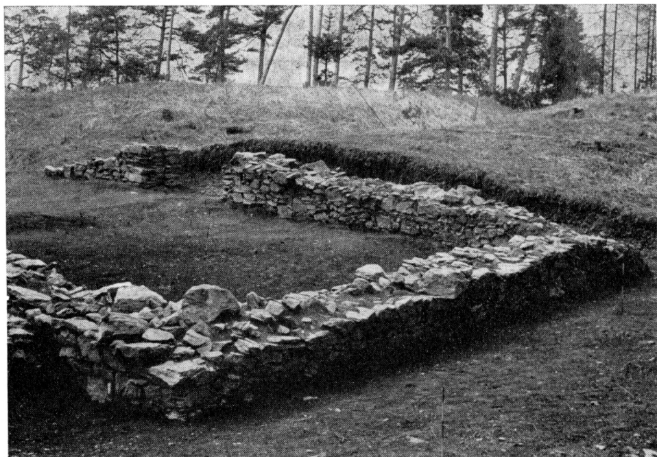
Obr. 1. Mstěnice, severní hrádek. Kamenné základy hospodářské budovy.
