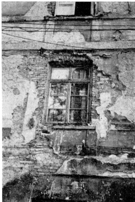
Obr. 5. Příbram, zámek. Detail severního okna ve východním průčelí. Vertikální omítkové pásy v 1. patře gotické stavby. Foto M. Glosová.
