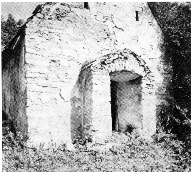
Obr. 11.–13. Ujezd u Chanovic (okres Klatovy), sýpka v usedlosti čp. 12 – půdorys, podélný řez, pohled na šiji. Samostatná kamenná sýpka s trémové zastropeným přízemím a horním podlažím s lepenecm, neseným hambalkovou konstrukcí. Vstup ve šitové stěně je opatřen mohutnou šiji s nikou v levé vstupní stěně, se sedlovou stříškou. Sýpka byla pravděpodobně postavena kolem roku 1800 nebo v 1. pol. 19. století. Kresba Z. Němcová, foto autor.
