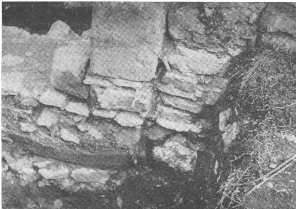
Obr. 5. Detail stavebnej cezúry v západnom obvodovom múre-exteriér. Foto Tóthová.
