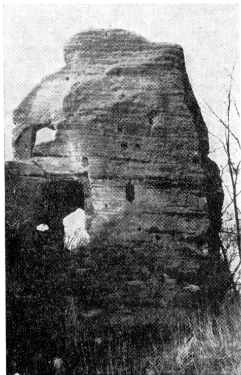
Obr. 4. Valečov. Skalní blok „věž“ v opevnění hradního jádra. Pohled od jihozápadu.
