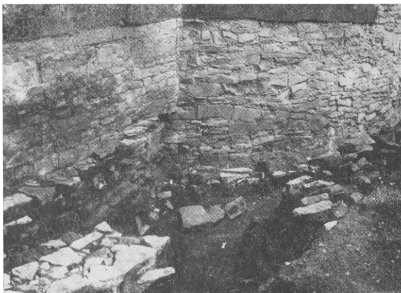
Obr. 6. Budeč, okr. Kladno, rotunda, zdivo lomové lodi, zdivo kvádkové (věž z 12. stol.).
