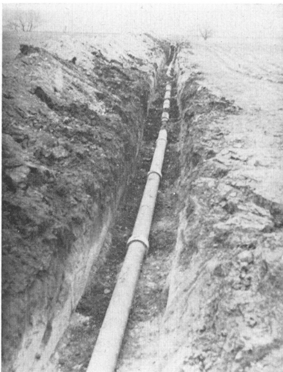
Obr. 3. Veľký Grob (okr. Galanta), ryha pre vodovodné potrubie.
