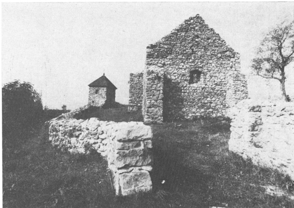
Obr. 7. Lúčka, okr. Rožňava – čiastočná rekonštrukcia a konzervácia objektov. Foto: Š. Fabián.
