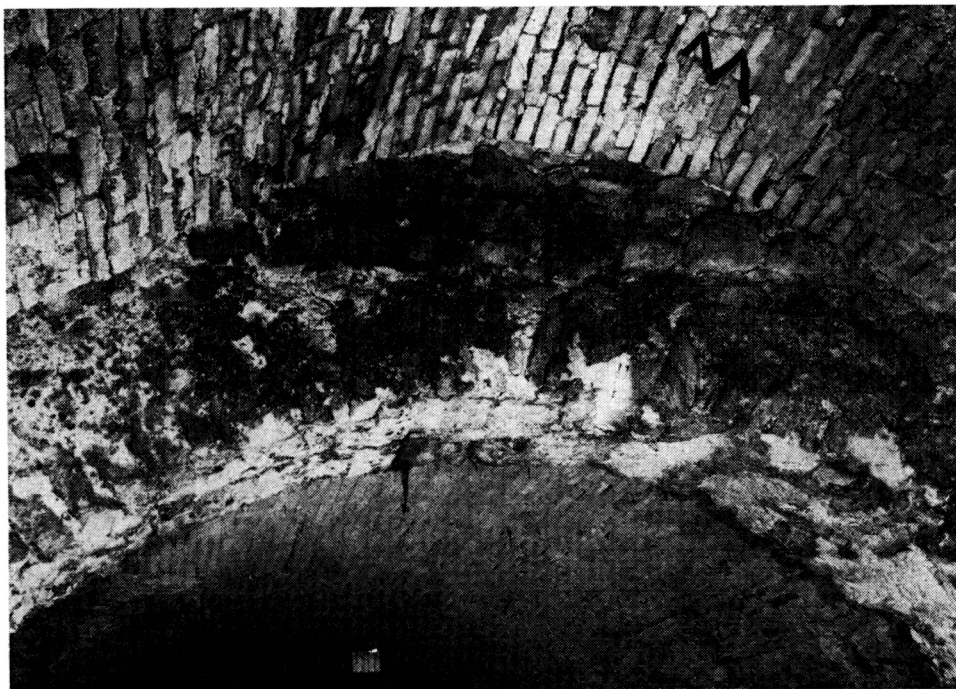
Obr. 5. Kamenný podklenutý pás v spodnom podlaží objektu Nálepškova 16, ktorý nesie priečku horného podlažia. Nad vrcholom oblúka je viditeľná pôvodná úroveň podlahy horného podlažia. Klenba je ranorenesančná. Foto: J. Schramek.
