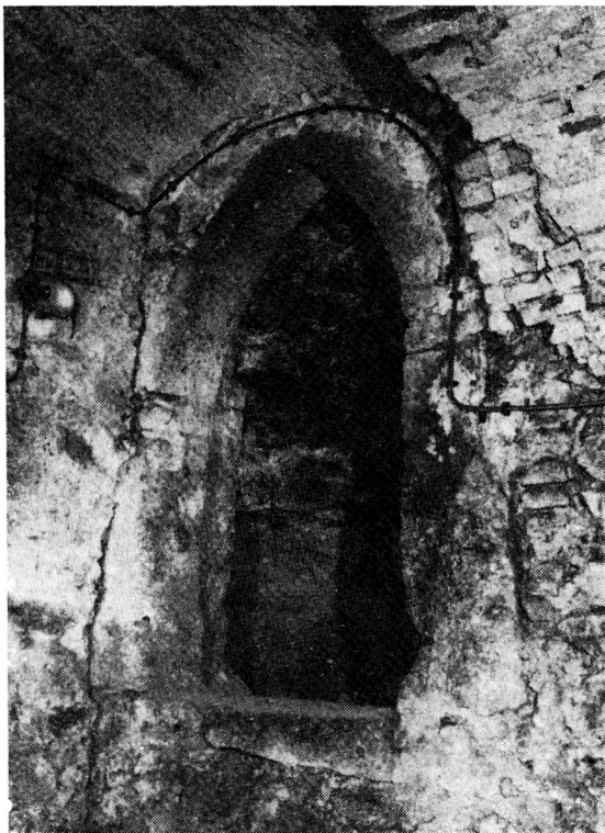
Obr. 5. Kamenný podklenutý pás v spodnom podlaží objektu Nálepškova 16, ktorý nesie priečku horného podlažia. Nad vrcholom oblúka je viditeľná pôvodná úroveň podlahy horného podlažia. Klenba je ranorenesančná. Foto: J. Schramek.
