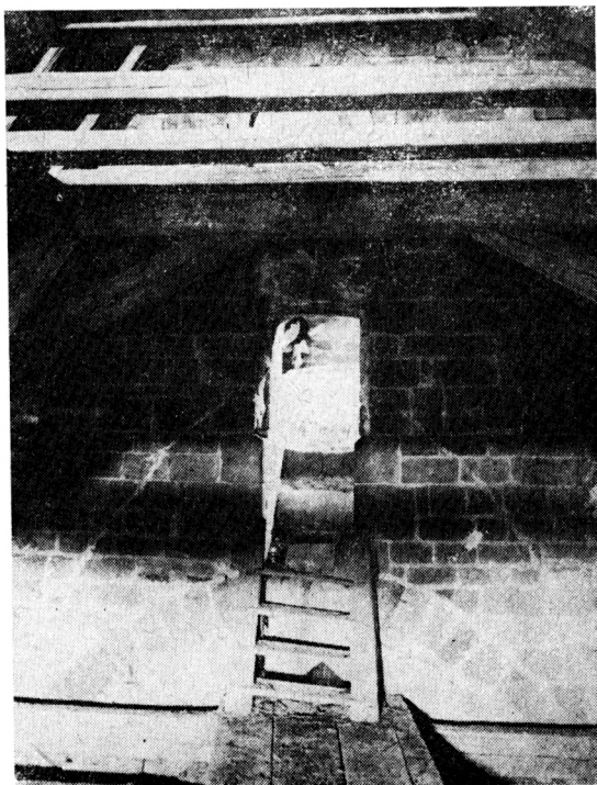
Obr. 8. Západní strana hranolovitého jádra stavby v dnešním podstřeší. Oblouk empory vespod, nad ním vstup do oktogonu a otisk střechy (?) westwerku. Fotoarchiv KSSPPOP Brno.
