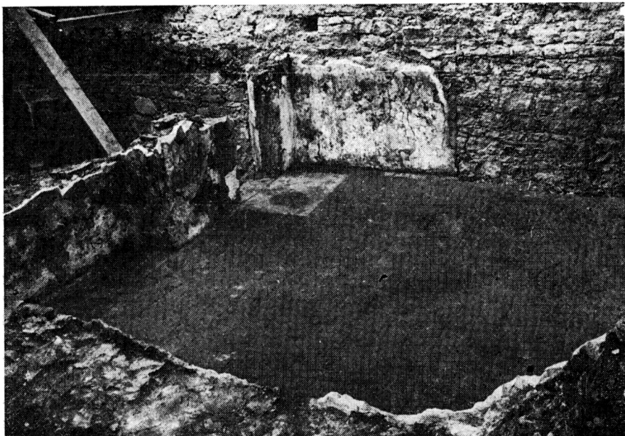
Obr. 4. Pohled od východu na mladší sakristii se vstupem do rotundy. Omítnuté zdivo po zřetelnou spáru představuje severní úsek východní štítové zdi obdélné lodi mladší fáze kostela. Neomítnuté zdivo vpravo od spáry souvisí s přestavbou svatyně na obytný dům po roce 1784. Foto V. Kvapil.
