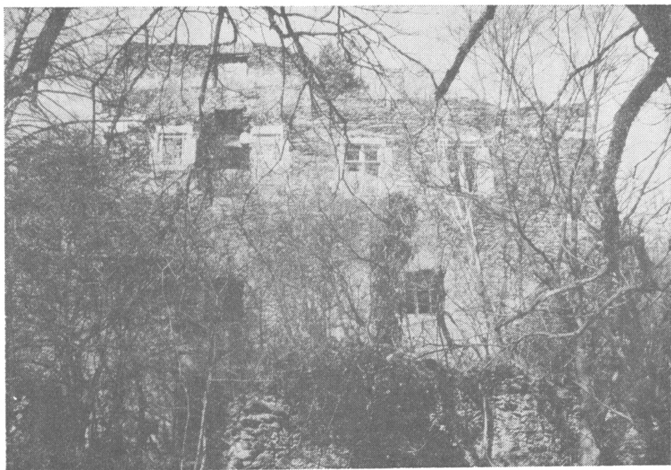
Obr. 13. Nový Hrádek u Lukova (okr. Znojmo). Objekt pozdně gotického předsunutého opevnění, který byl na konci 15. století přestavěn na hlavní obytnou budovu hradu.
