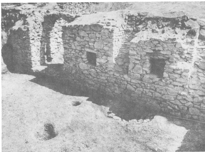
Obr. 3. Lelekovice-hrad. Sklep E od jihozápadu se vstupem, výklenky, šikmými okny a jámkou.
