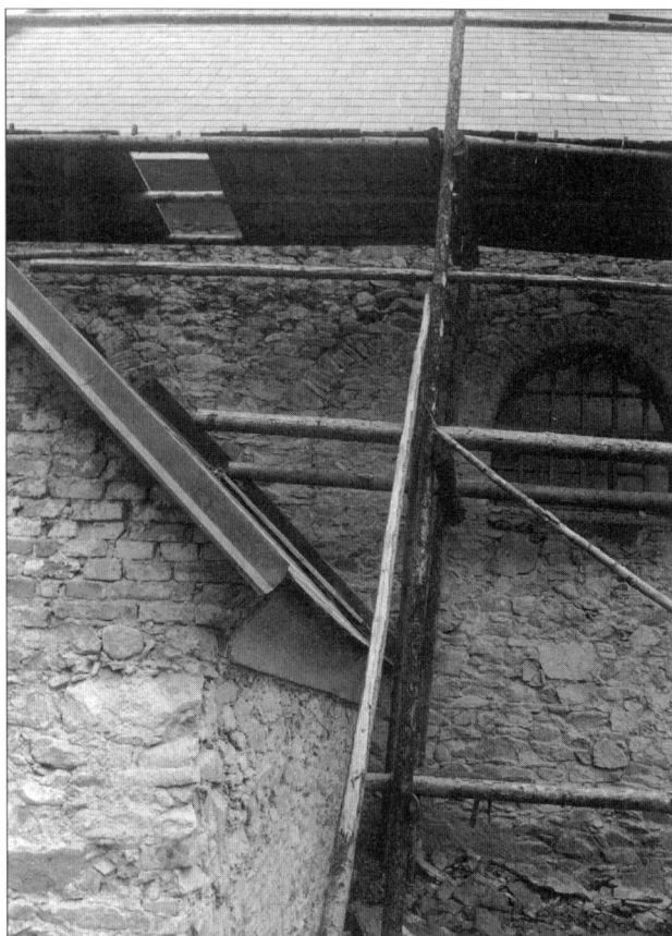
Obr. 5. Jenkov, jižní strana lodi s nálezem ostění gotického okna a druhého západního okna, zatím nejasného původu. Foto M. Glosová.
