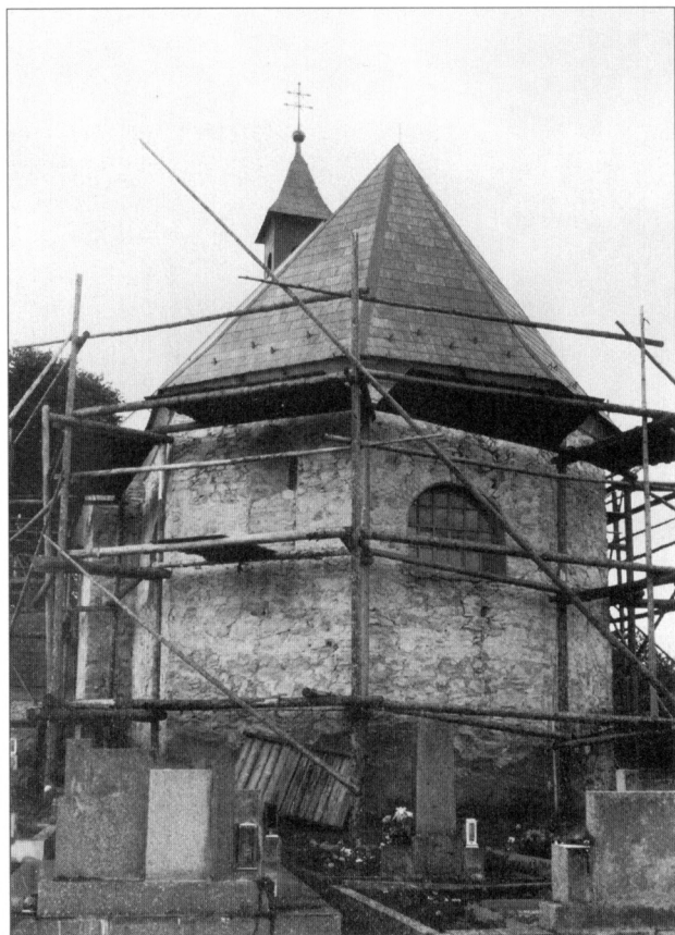
Obr. 4. Jenkov, nálezev zadržaného pávodního gotického okna v jižní- chodní stěně presbytáře. Foto M. Glosová.
