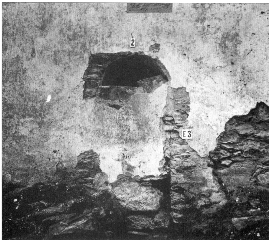
Obr. 3. Pôvodný severný portál.
