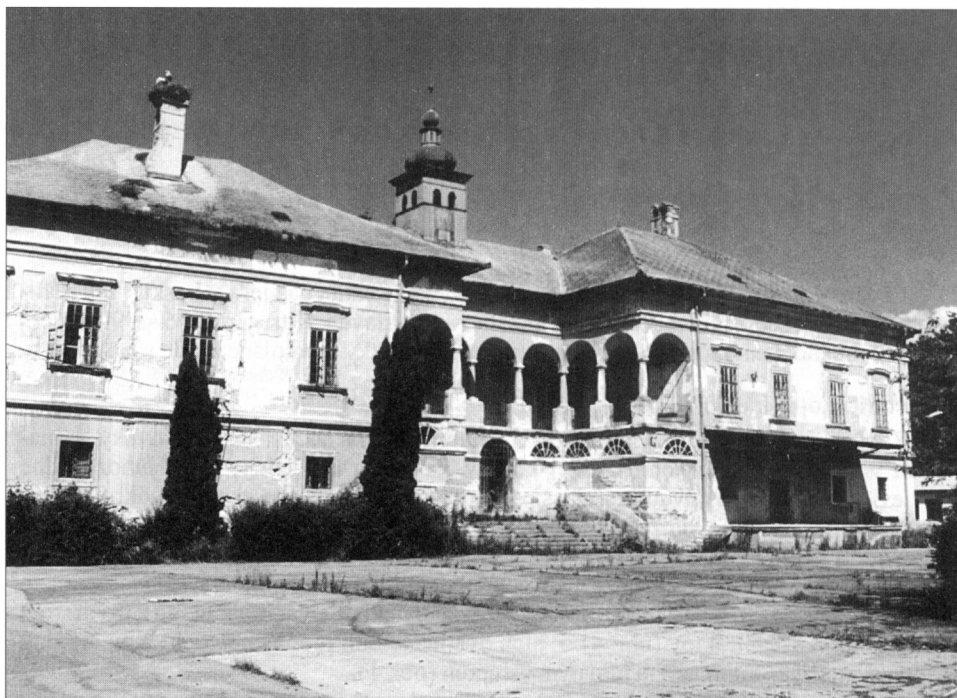
Obr. 1. Celkový pohľad na kaštieľ od juhu pred asanáciou. Foto: Bóna V/97.
