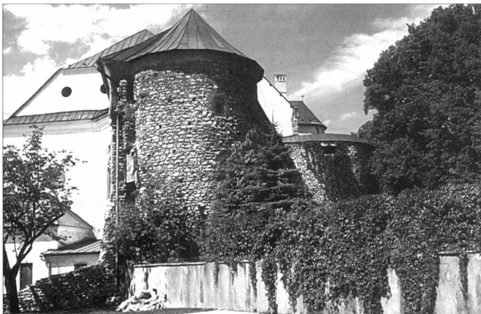
Obr. 4. Pohľad na Gallovu (pisársku) baštu, v pozadí Banická bašta. Fotografia: Igor Graus.
