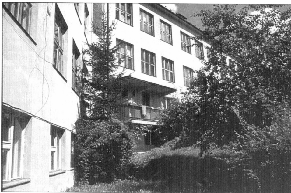
Obr. 11. Pohľad na zadný trakt budovy školy v priestore ktorého pôvodne stála Ondrejova bašta. Fotografia: Igor Graus.
