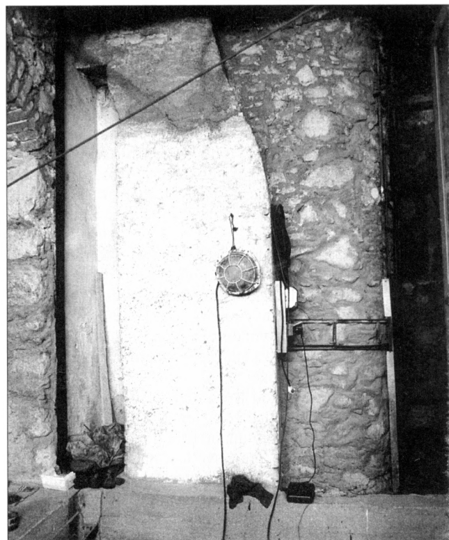
Obr. 8. Detail komína v podkrovi veže.
