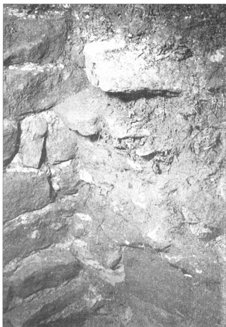
Obr. 25. Kostel sv. Klimenta. Sonda 2/1997. Struktura zdiva severovýchodního nároží lodi a jeho základový vkop. Detail. Foto Jar. Špaček.
