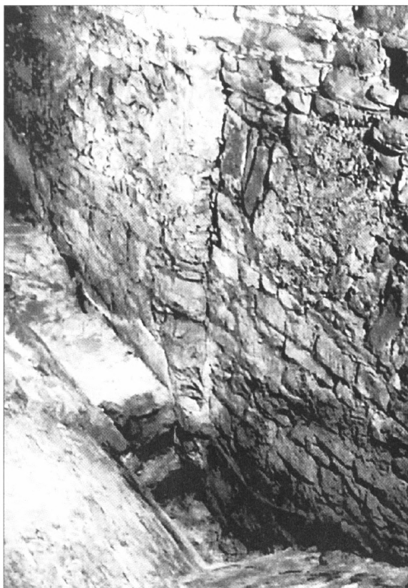
Obr. 18. Bazilika sv. Václava. Vrábská kaple/2000. Spára s vynášecím půbloukem v severním lici severní zdi hlavní lodi. Západní část řezu 4, zdivo 10912a a 10913. Foto Jiří Špaček.
