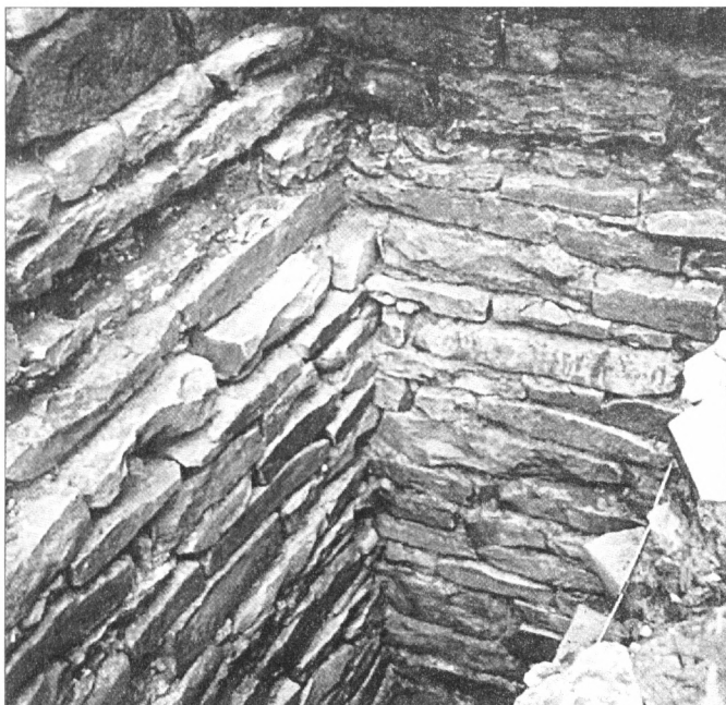
Obr. 8. Bazilika sv. Václava. Sonda 4/1998. Provázání západního čela Vrábské kaple se severní obvodovou zdí baziliky v pohledu od severozápadu. Detail. Foto I. Boháčová.
