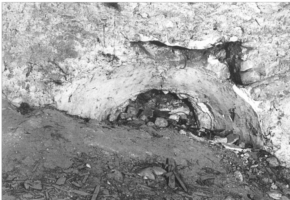
Obr. 22. Bazilika sv. Václava. Vrábská kaple/2000. Detail zazděného okénka v severní stěně. Západní část řezu 1. Foto Jiří Špaček.
