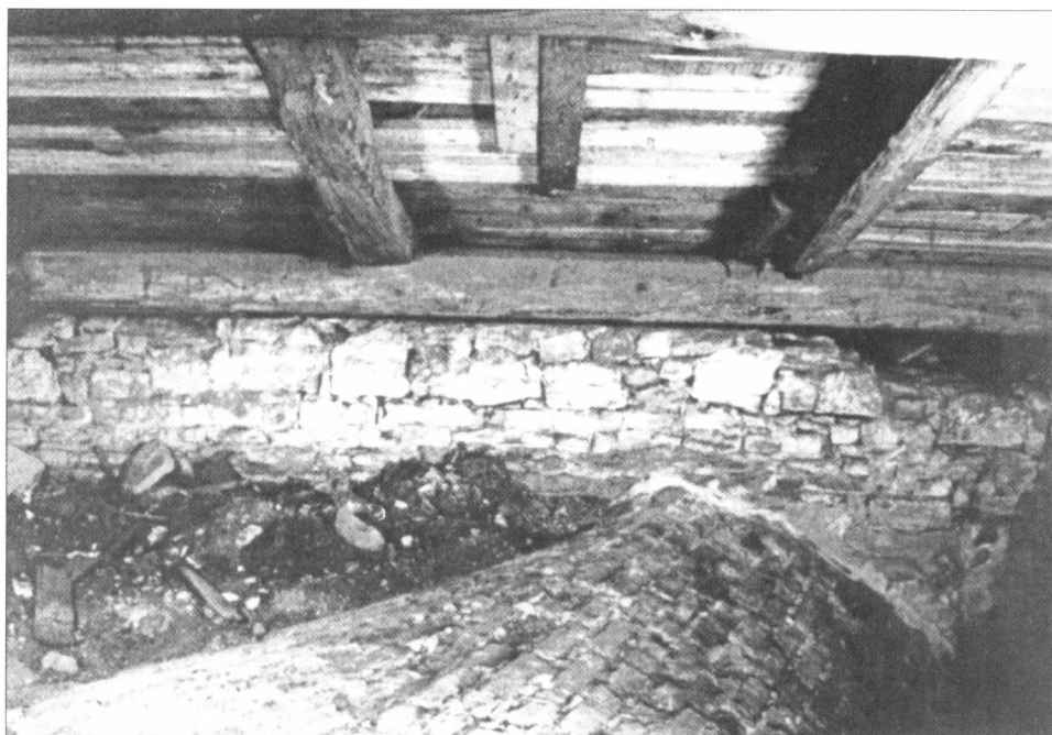
Obr. 17. Bazilika sv. Václava. Vrábská kaple/2000. Jižní líc severní obvodové zdi, prostor řezu 6. Foto Jiří Špaček.
