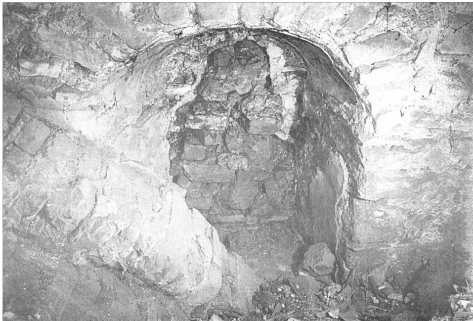
Obr. 23. Bazilika sv. Václava. Vrábská kaple/2000. Detail zazděného okénka v západní stěně. Řez 5. Foto Jiří Špaček.
