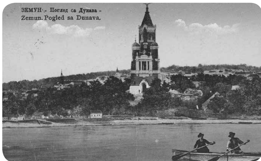
6. Věž tisíciletí na zemunském Gardoši na kolorované pohlednici z počátku 20. století. Zdroj: archiv M. K.
