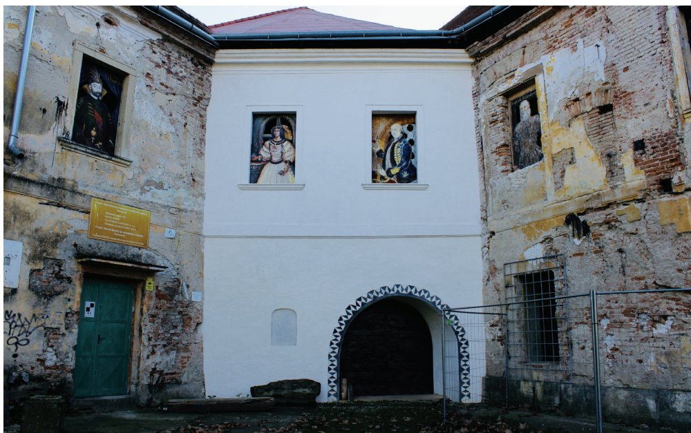
Obr. 19. Detail na zrekonštruovaný bastión, pohľad z nádvorja. (Foto D. Drobná)
