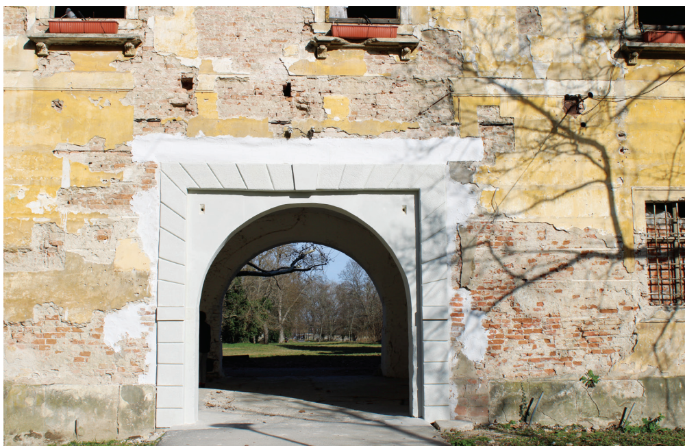
Obr. 22. Detail na portál z roku 1600 po rekonštrukcii. (Foto D. Drobná)
