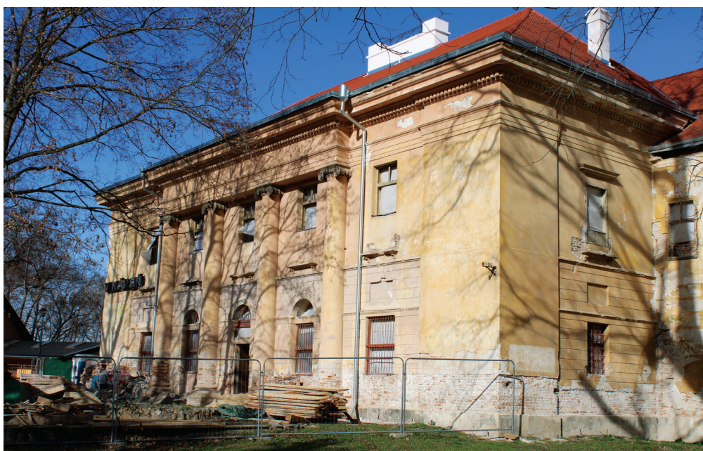
Obr. 20. Západná fasáda severnej časti západného krídla s klasicistickým rizalitom a štvoricou iónskych pilastrov (Foto D. Drobná)
