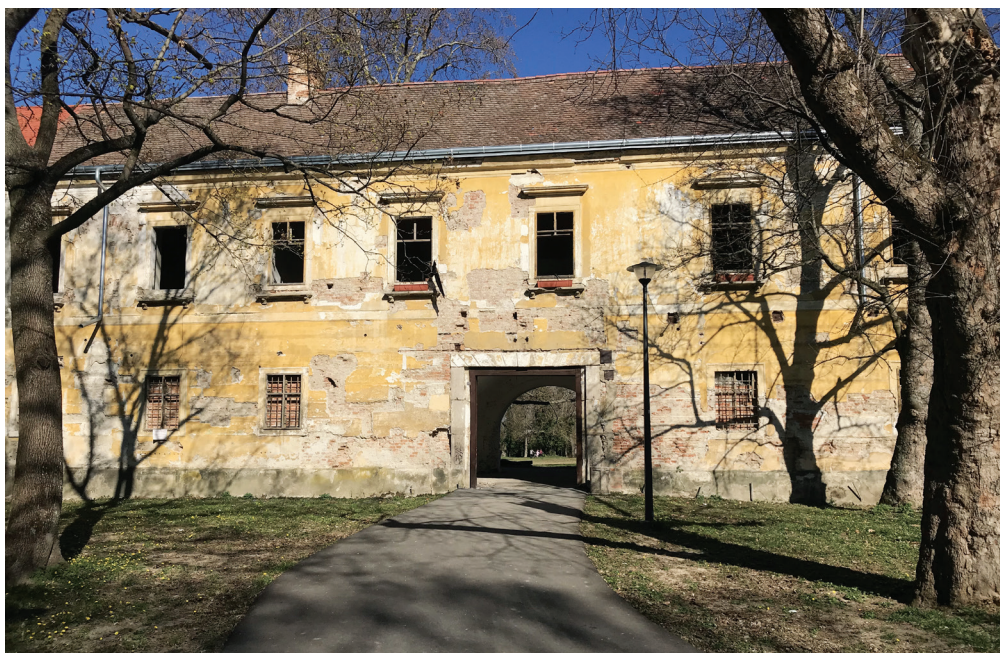
Obr. 21. Pohľad na vstupnú bránu pred rekonštrukciou. (Foto D. Drobná)
