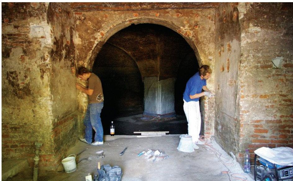
Obr. 16. Záber z čistenia stien bastiónu kaštieľa, ktorý vznikol v 16. storočí. (Podľa http://www.vodnyhrad.sk/data/sprava_z_kastiela/6.jpg )
