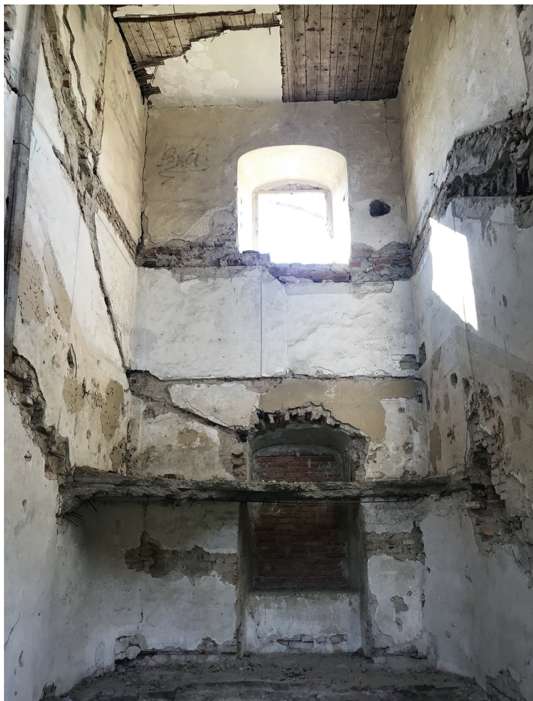
Obr. 23. Pohľad do interiéru južného krídla. (Foto D. Drobná)
