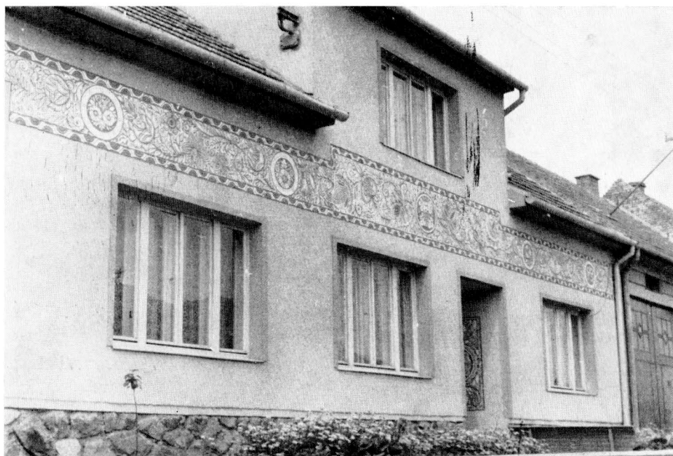
Pronikavě přestavěný dům č. p. 248 se sgrafitovým vlysem. Foto R. Jeřábek 1974. ▼
