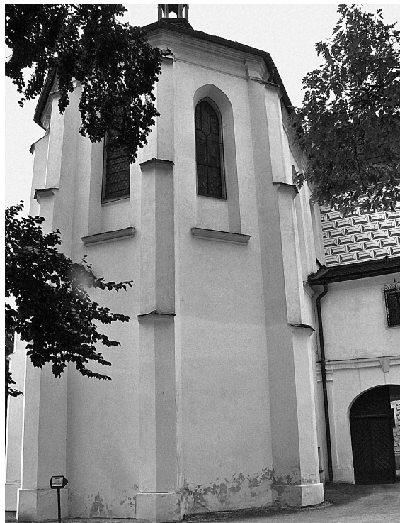
Obr. 3: Březnice, zámecká kaple, před 1632, pohled od severovýchodu.
