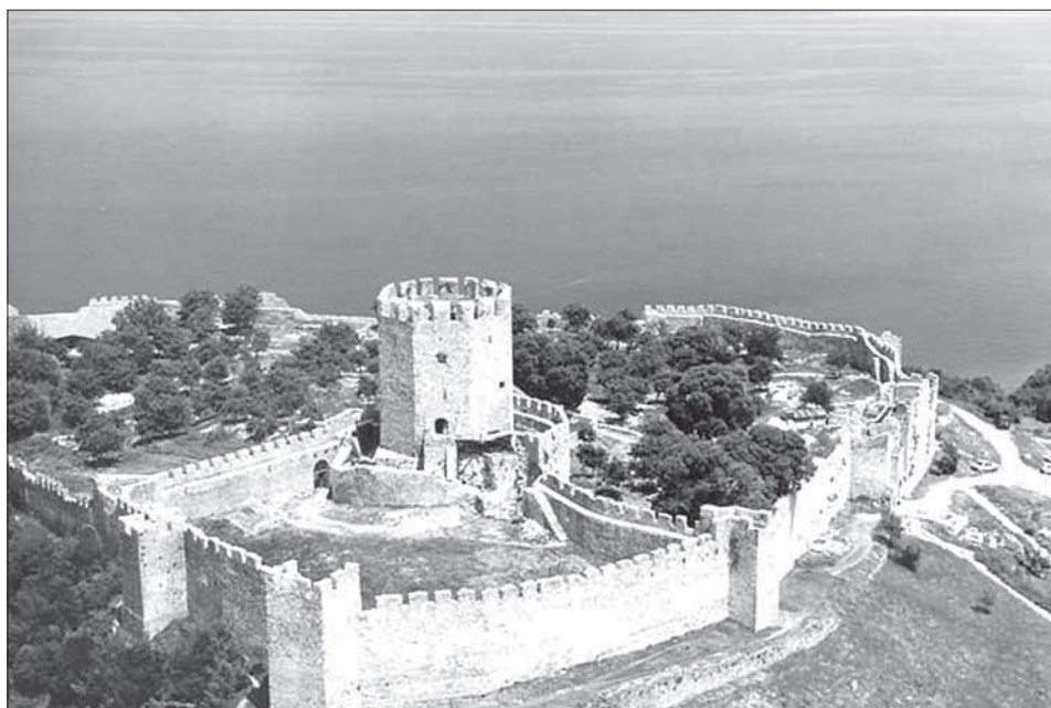
Obr. 5. Oktagonální věže v Rakousku, na Moravě a v Řecku. Nahoře vlevo: věž v nároží městských hradeb v Hainburgu an der Donau. Nahoře uprostřed: Loupežnická věž ve Znojmě. Podle Prokop 1907. Nahoře vpravo: Gars am Kamp, pohled do interiéru. Dole: Platamonas, letecký pohled. Foto autor a archiv autora.
