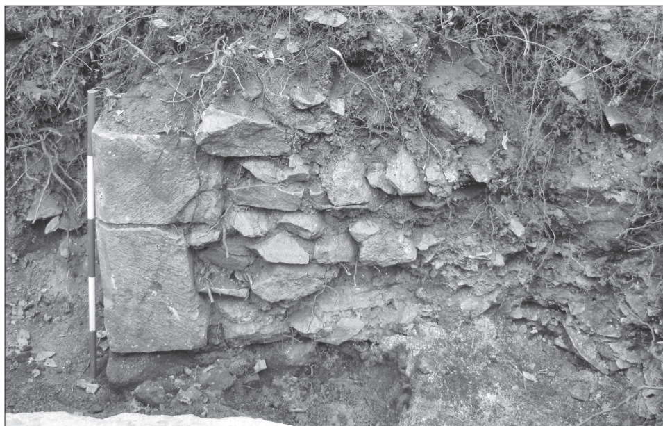
Obr. 4. Hrad Šaumburg (k. ú. Rajnohovice). Detail východní stojky otvoru, pohled od jihovýchodu. Foto R. Vrla, 2010.
