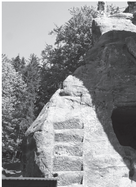
Obr. 6. Hrad Frýdštejn, okr. Jablonec nad Nisou. Stopy zděného základu stavby přisekané do ukloněného pískovcového podloží. Foto I. Peřina.
