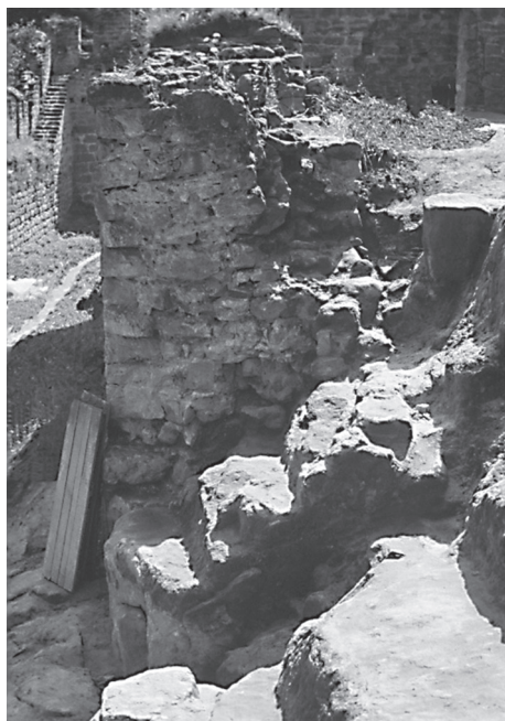
Obr. 4. Hrad Helfenburk, okr. Litoměřice. Vodorovné stopy založení hradby, zachované v pozadí. Foto F. Gabriel.
