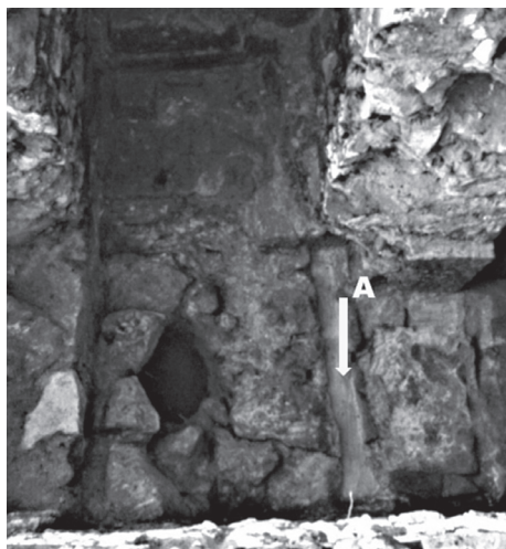
Obr. 14. Hrad Lipý, okr. Česká Lípa. Novověký průraz zdi paláce se spárou jílové izolace (A). Foto F. Gabriel.
