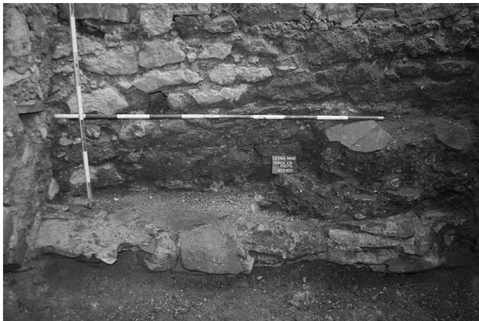
Obr. 8. Hrad Lietava, okr. Žilina. Sonda 21 – spadnutá klenba v Kostkovej prístavbe.
