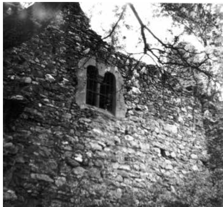
Obr. 5. Rabštejnek, k. ú. Smrkový Týnec, okres Chrudim. Pohled na západní stranu hradního jádra. V prostoru mezi dvěma opěráky se nalézá zamřížované pseudorománské okénko. Stav z roku 1959. Fotografie ze sbírky M. Vorla.
