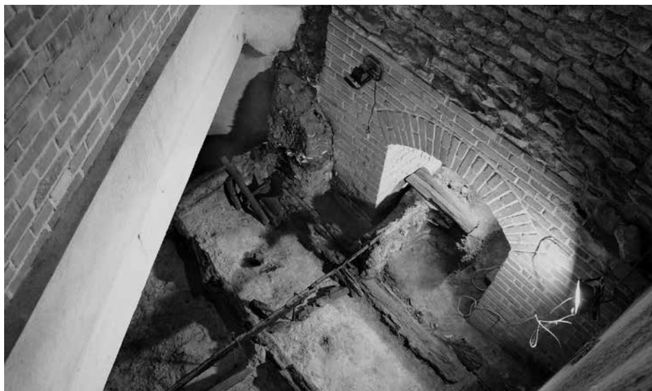
Obr. 12. Pražský hrad, III. nádvoří. Prostor při románské chodbě v pohledu shora od jihu. Vlevo betonová nosná konstrukce se zdivem východní stěny románské chodby, dole centrální část srubové stavby s vertikálními dubovými prvky z 30. let 10. století. V zadním rohu torzo sídlištního souvrství s dochovaným zánikovým (požárovým?) horizontem stavby a jeho nadložím, dokládajícím nástup mladohradištní keramiky. Foto M. Semerád, 2014.
