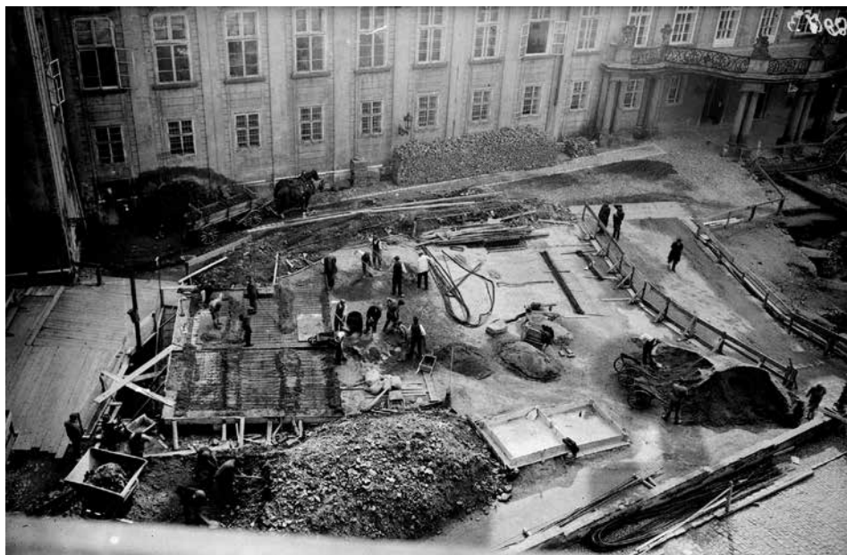
Obr. 13. Pražský hrad, III. nádvoří. Dobový snímek zachycující postup zakrývání areálu železobetonovou deskou. ARÚ AV ČR, Praha, FT000103263.
