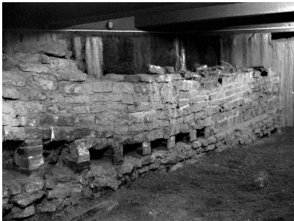
Obr. 14. Pražský hrad, III. nádvoří. Severní část románské chodby spojující baziliku s jednoduchým románským kostelem po zásypu povrchu historických terénů pískem. Foto I. Boháčová, 1998.
