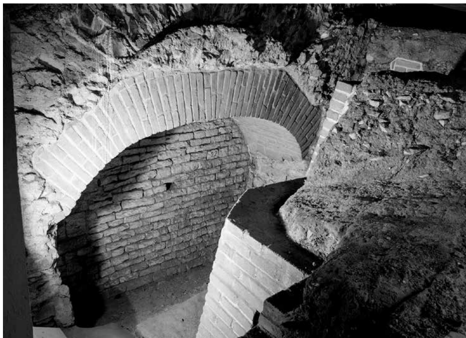
Obr. 7. Pražský hrad, III. nádvoří. Románská hradba (obr. 2 – hradba C), zděná z opukových kvádrů na maltu. Zachována je při jižním okraji areálu, pohledově je zpřístupněná systémem průzorů a vydívek. Průhled mezi obezdívkou vyrovnávacích terénních vrstev a základovým zděním jižního křídla na obezděný severní líc hradby.
