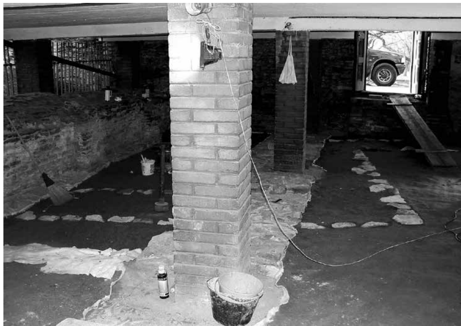
Obr. 17. Praha – Vyšehrad. Pohled ze střední části hlavní lodi k jihozápadu. Stav po zasypání podloží zhruba do výše rozhraní základového a nadzemního zdiva se stylizovanou rekonstrukcí průběhu jihozápadní části zdiva předrománské stavby. Foto J. Mjartan, 2011.
