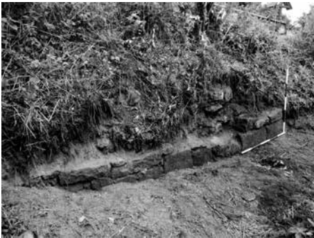
Obr. 14. Přimda, okr. Tachov. Zdivo s kvádřovým lícem a nárožím pod západní hranou horního nádvoří, pohled od severozápadu. Foto P. Sokol, 2012.
