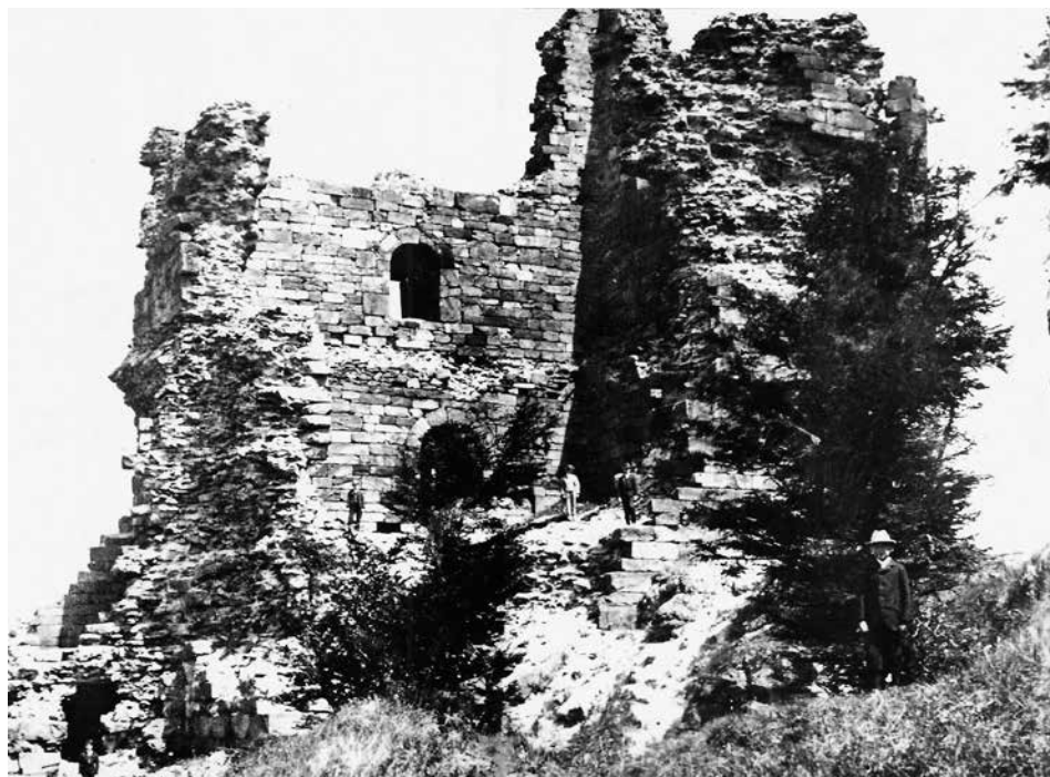
Obr. 7. Přimda, okr. Tachov. Donjon od jihozápadu na fotografii pravděpodobně z konce 19. století. Na zřejmě nejstarší fotografii donjonu je zachycen jeho stav před razantními opravami 20. století. Fotoarchiv NPÚ ÚOP v Plzni. Abb. 7. Přimda, Bezirk Tachov. Donjon von Südwesten auf einer Fotografie von wahrscheinlich Ende 19. Jhdt. Die offenbar älteste Fotografie des Donjons gibt dessen Zustand vor den rasanten Änderungen des 20. Jahrhunderts wieder. Fotoarchiv Nationales Denkmalinstitut regionale Fachstelle in Pilsen.
