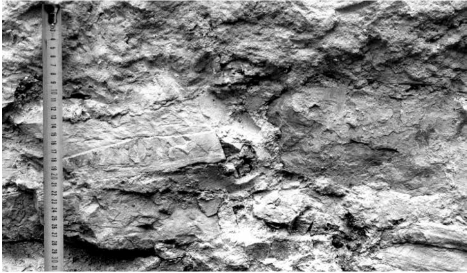
Obr. 3. Nitrianska Blatnica, Rotunda sv. Juraja. Fragmentárne zachovaná primárna povrchová úprava severnej fasády rotundy. Foto M. Bóna, 2001.
