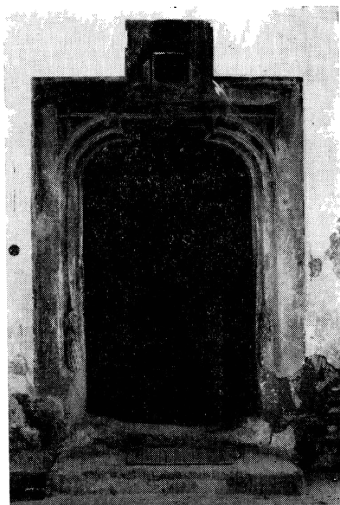
Obr. 2. Parížovce, kaštieľ. Detail vstupného neskorogotického portálu s erbom v nadpraží. Foto Š. Bukjár.
