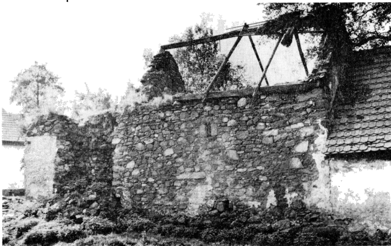
Obr. 7. Strážovice (okres Klatovy), usedlost čp. 10 – zbytky domu. Obytná část domu je už zbořena; stojí zbytky střední části komunikační, přestavěné v 19. století (vlevo) a starší patrová sýpka v zadní části domu. Sýpka je z kamenného lomového zdiva, se šůty, na jejichž ústupky byla usazena dřevohlinitá konstrukce lepence. Nad lepencem byl na hřebenové vaznici, zachycené na vrcholech žitíů, zavěšen lehký krov s doškovou krytinou. Foto autor.
