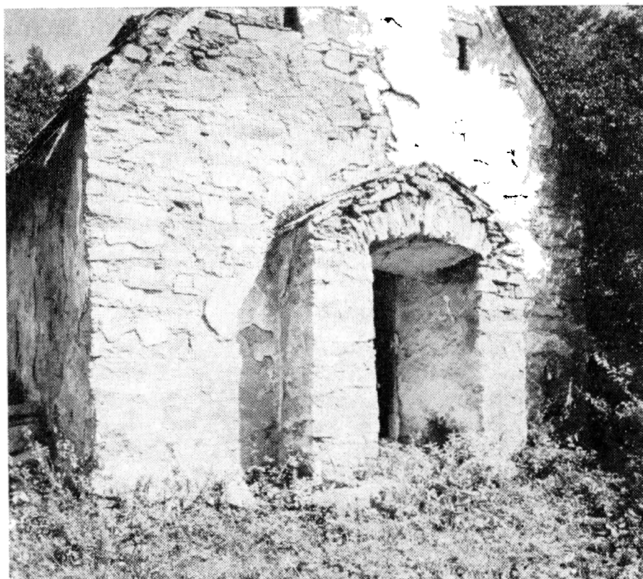
Obr. 11.–13. Újezd u Chanovic (okres Klatovy), sýpka v usedlosti čp. 12 – půdorys, podélný řez, pohled na šiji. Samostatná kamenná sýpka s trémově zastropeným přízemím a horním podlažím s lepenecem, neseným hambalkovou konstrukcí. Vstup ve štítové stěně je opatřen mohutnou šiji s nikou v levé vstupní stěně, se sedlovou stříškou. Sýpka byla pravděpodobně postavena kolem roku 1800 nebo v 1. pol. 19. století. Kresba Z. Němcová, foto autor.
