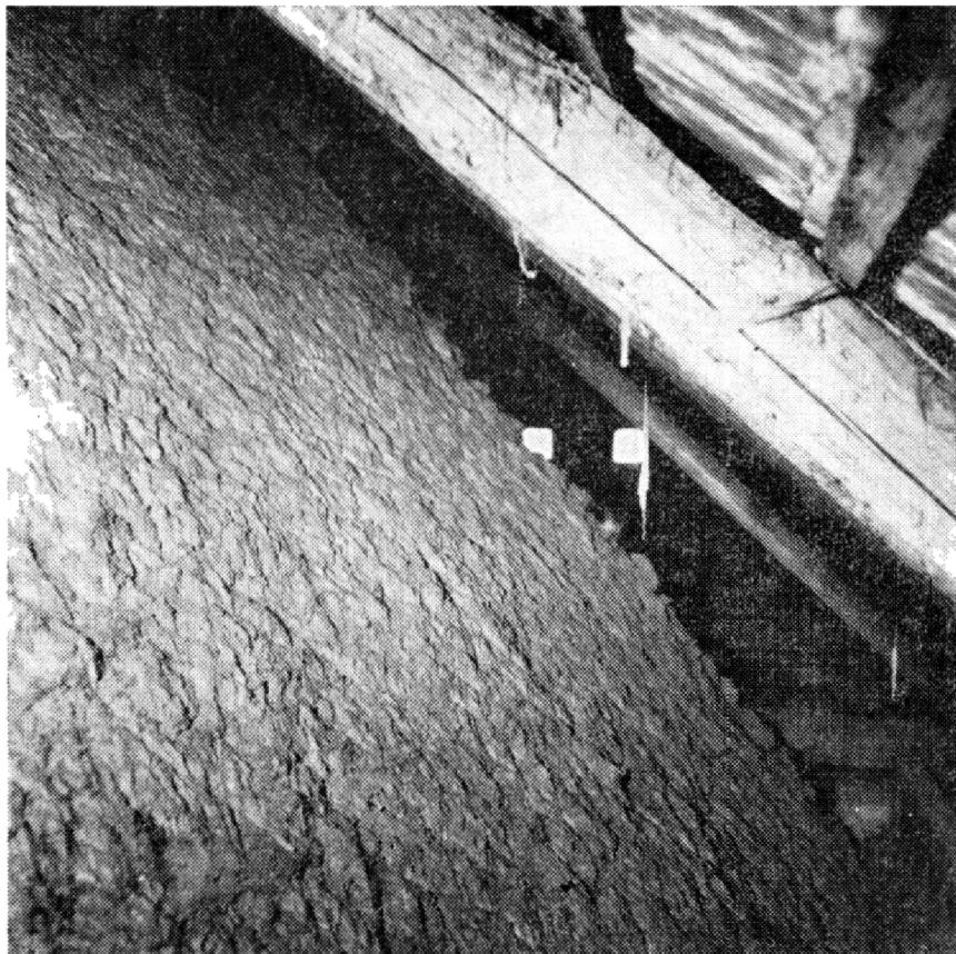
Obr. 6. Břežany (okres Klatovy), dům zemědělské usedlosti čp. 47. Průhled mezerou mezi lepencem nad patrem sýpky a krovem směrem ke žitíu domu. Sýpka patří ke staršímu jádru domu, přestavovaného v obytné části v 19. a 20. století. Foto autor.
