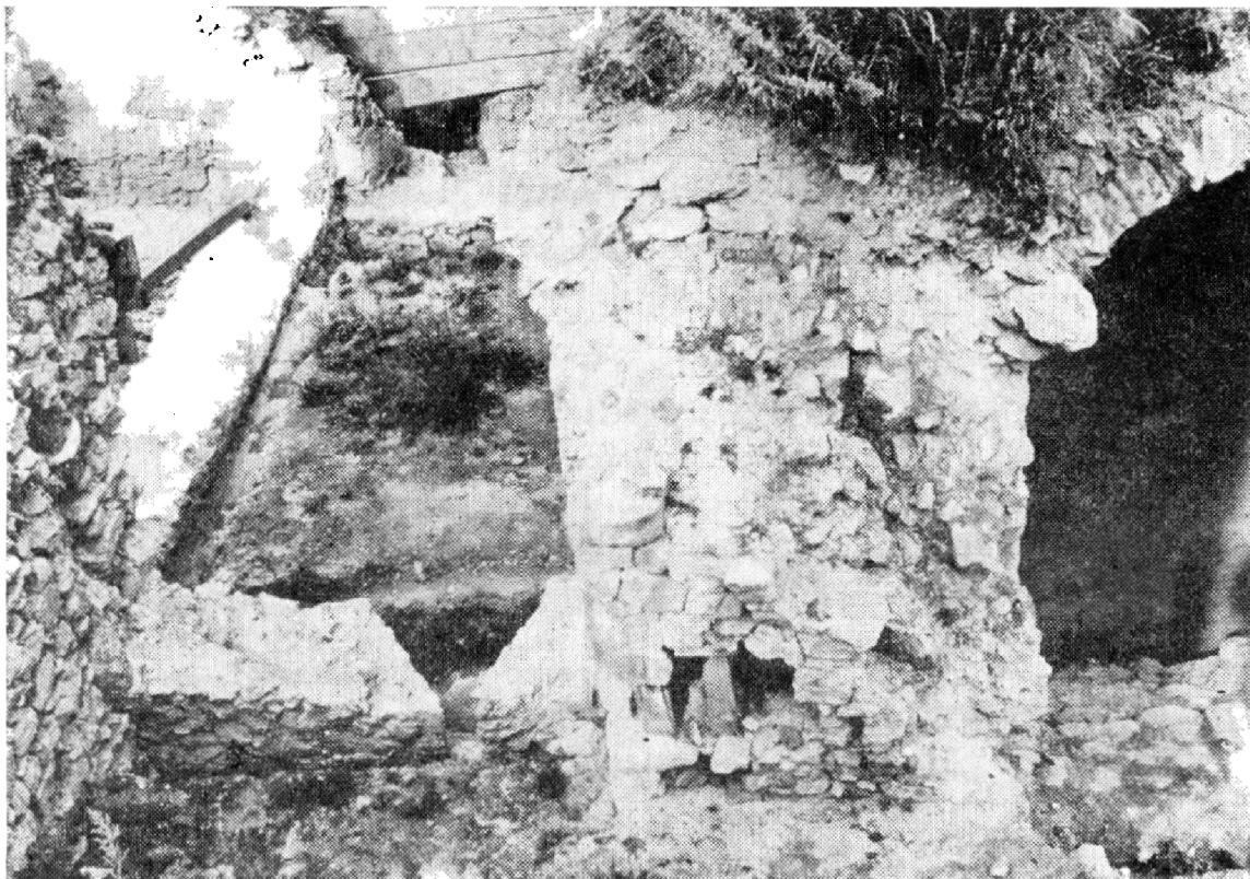
Obr. 3. Beckov, hrad. Časť odkrytého paláce č. 2. Foto D. Tóth.
