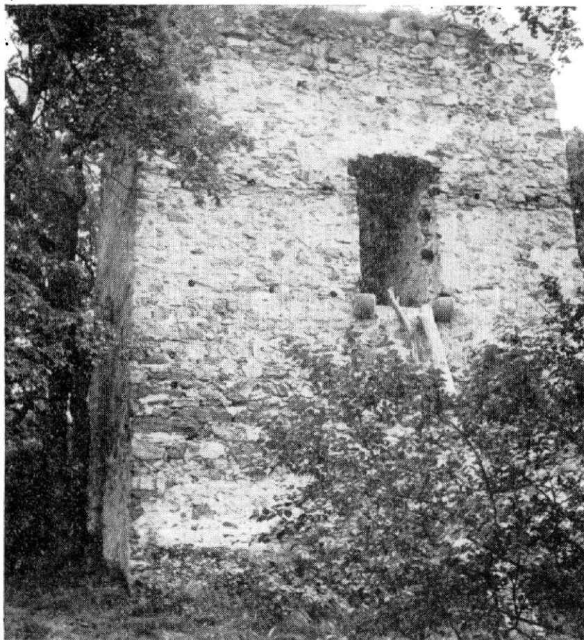
Obr. 11. Pozdněgotická předsunutá věž před Cornštejnem.
