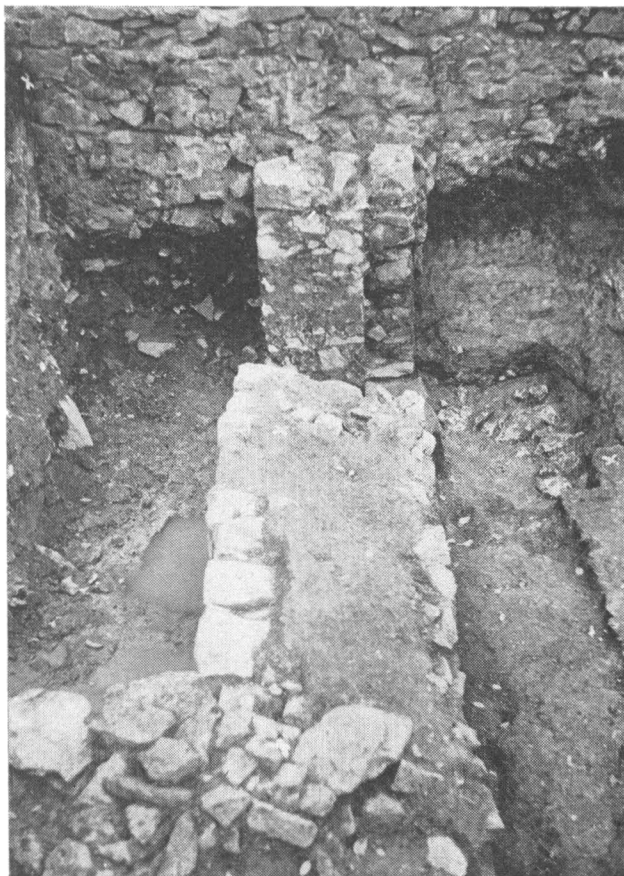
Obr. 8. Čimice (Praha 8). Zápklady kamenného domu. Foto: Fr. Čáp.
