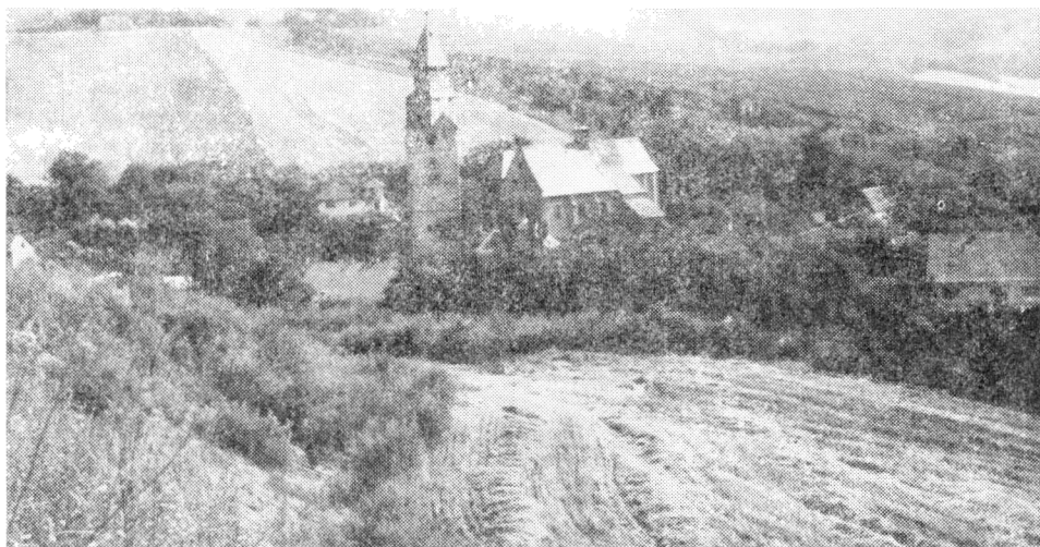
Obr. 2. Kurdějov, okr. Břeclav. Celkový pohled na opevněný kostel od jihozápadu. Foto: V. Prokop.
