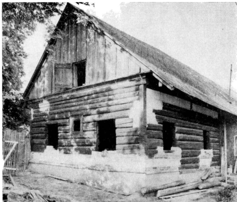
Obr. 1. Lučice čp. 2 (okr. Klatovy), celkový pohled na obytnou část domu po sejmutí hliněné omazávky a náhrado narušených prvků roubené konstrukce. Stav 1962.
