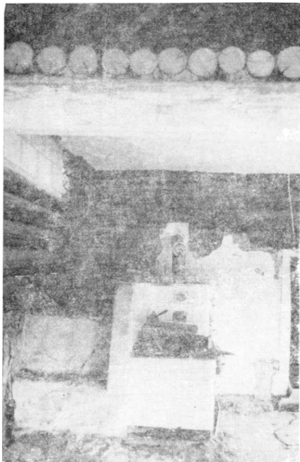
Obr. 2. Lučice čp. 2 (okr. Klatovy), pohled do kouta obvino místnosti s otopným zařízením (odleva pec, vytápěná z mladší černé kuchyně, sporák a vstup ze síně). Nahoře čela stropních povalů, uříznutých v polovině místnosti nad hraněným stropním trámem. Stav 1982.
