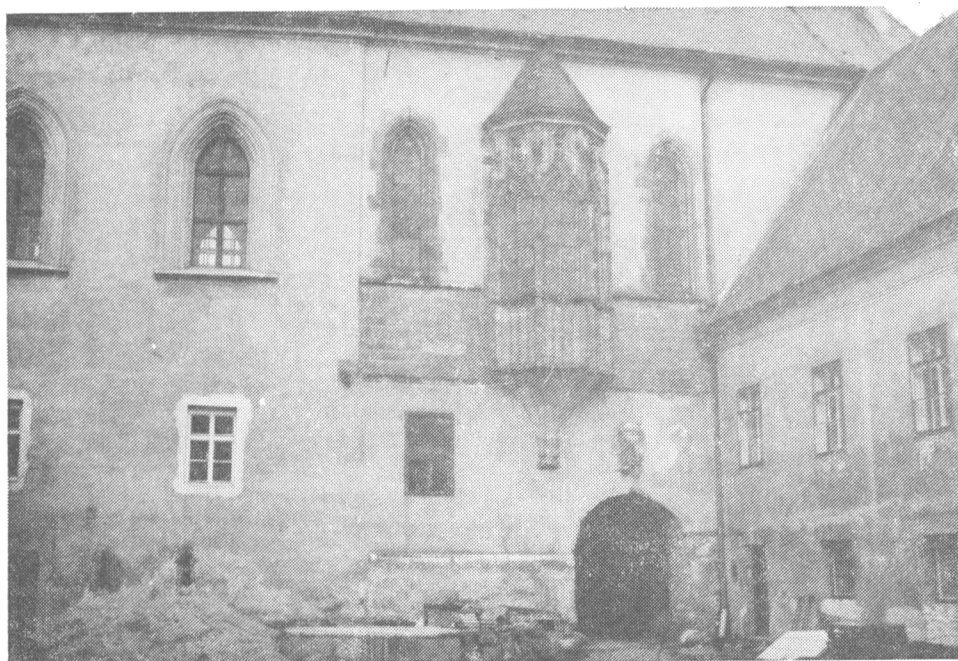
Obr. 5. Lomnice u Tišnova (okr. Blansko). Arkýř pozdně gotické kaple.
