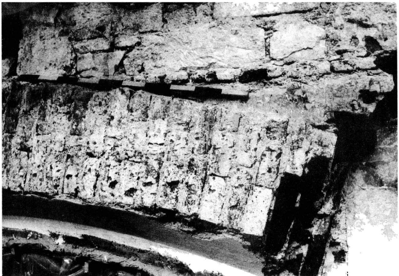
Obr. 8b. Jižní portál s lomeným obloukem. Foto: K. Špoutil.
