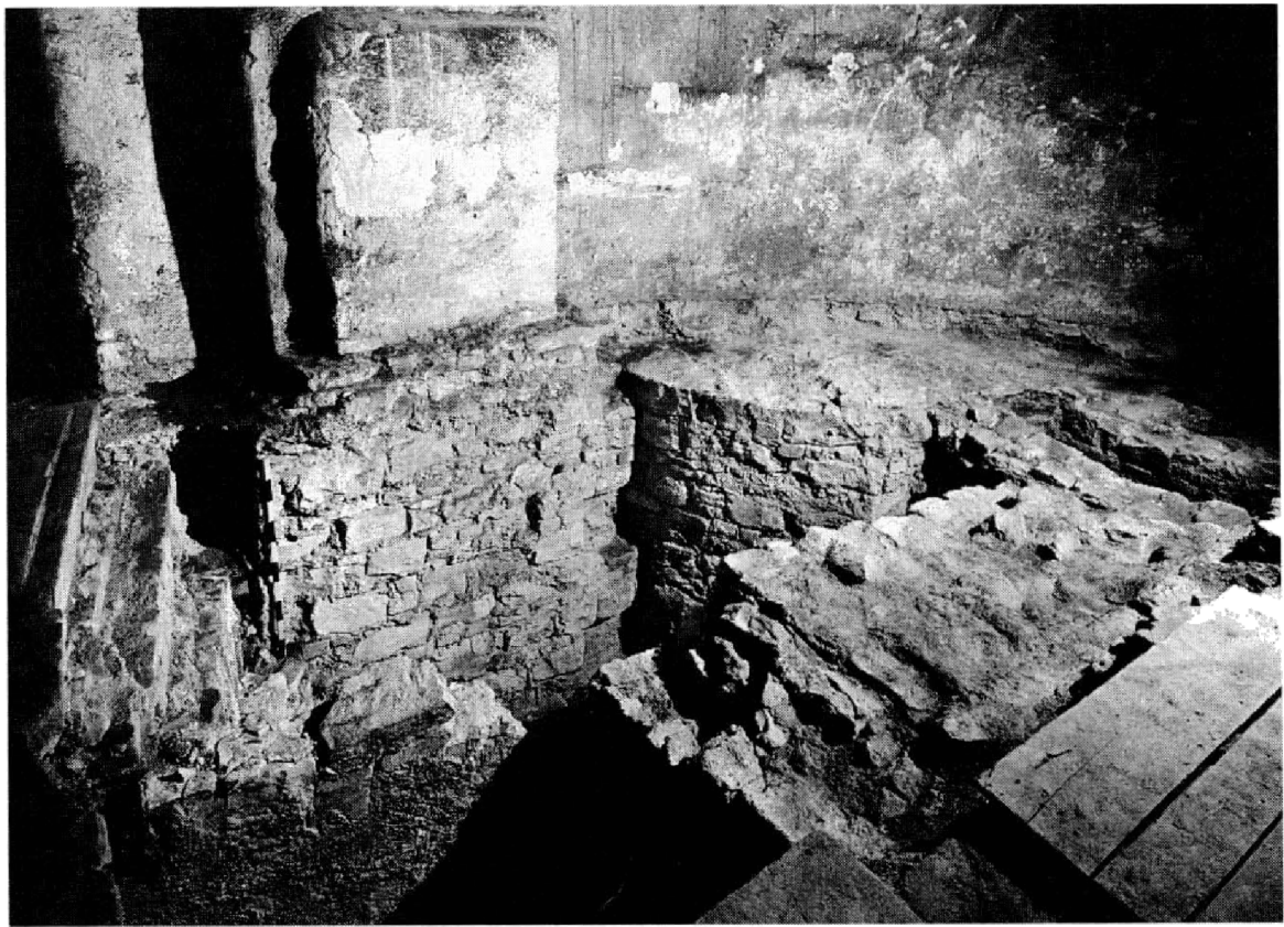
Obr. 6. Východní apsida se základy pilíře vítězného oblouku. Pohled od JV. Foto: VI. Uher.
