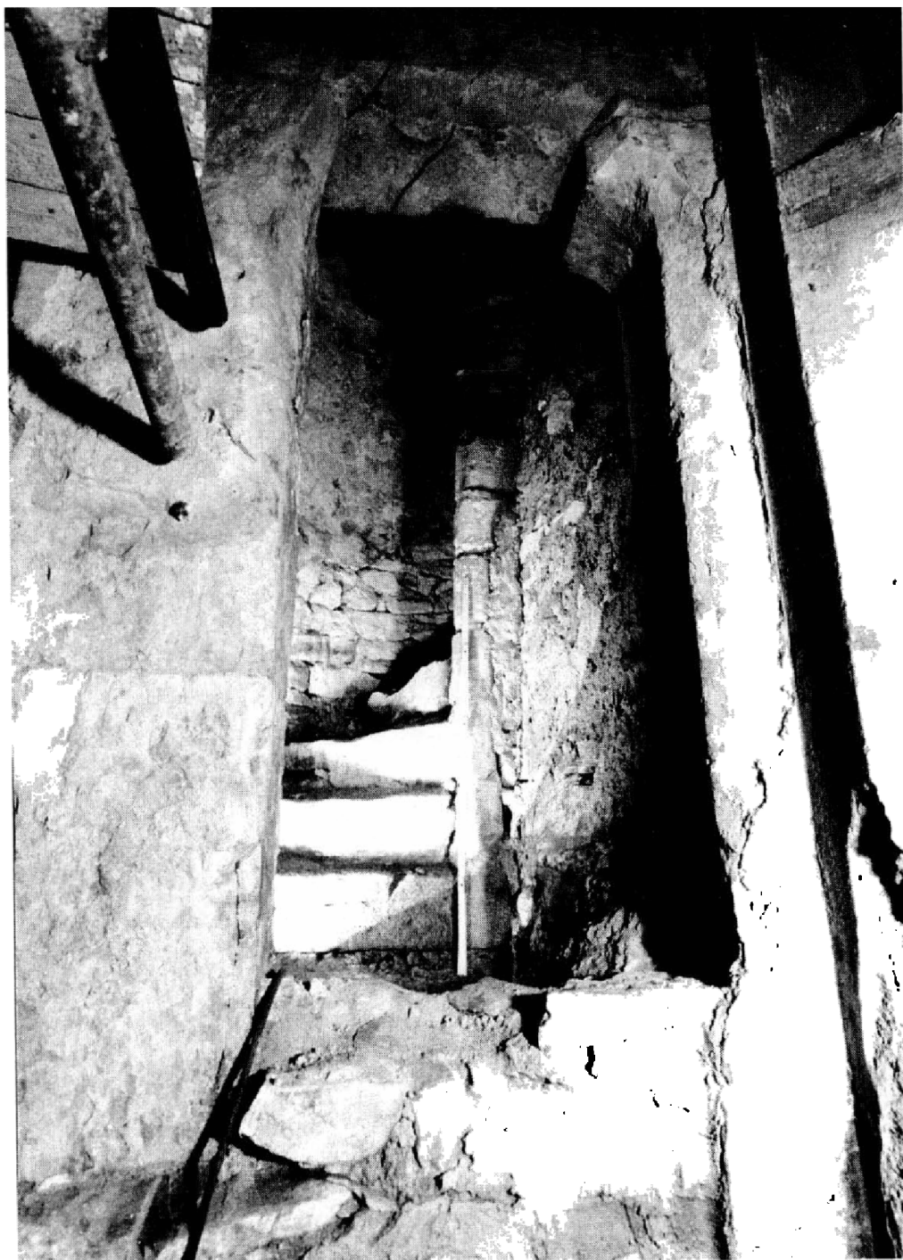
Obr. 5. Sedlový portálek schodiště v západní části hlavní lodi. Foto: Fr. Malý.
