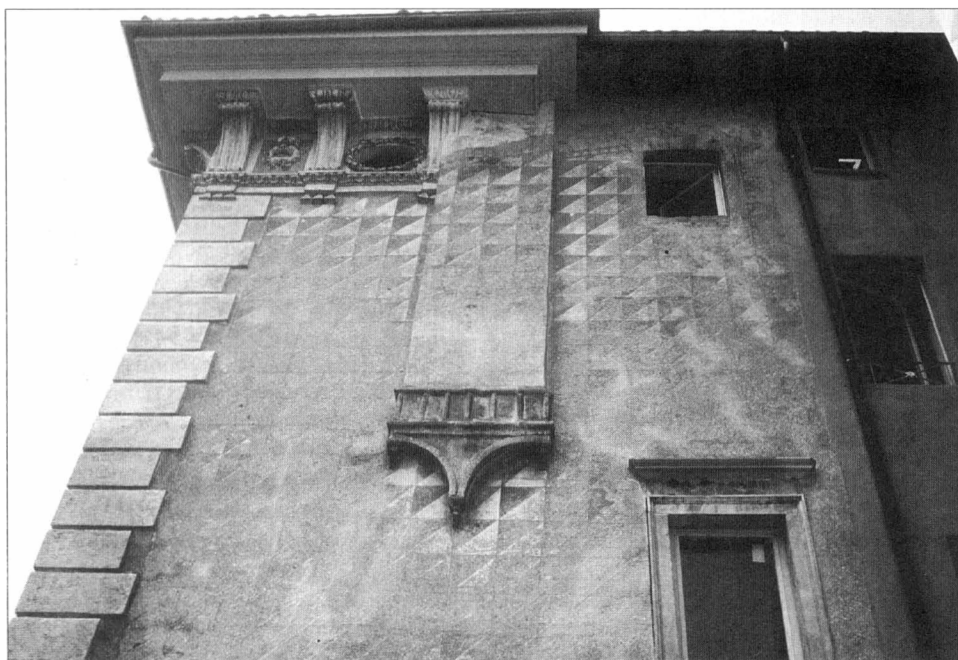
Obr. 5. Morcote (Švajčiarsko, kantón Ticino), dom č. 27 na Riva dal Drera.
