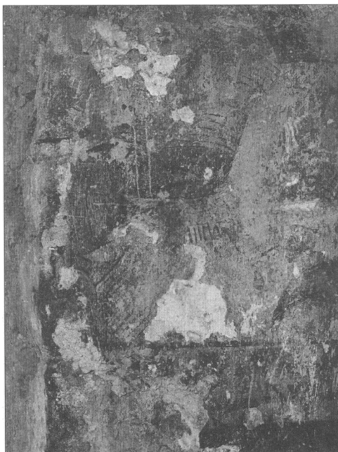
Obr. 14. Špaleta lomeného portálu vo východnej časti 1. poschodia južného krídla, stav po odkrytí maľby v roku 1962 (Archív Slovenského pamiatkového ústavu Bratislava).
